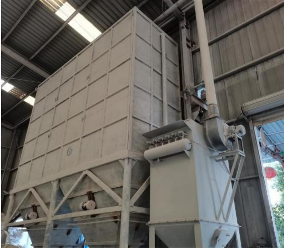
图 3-5 四号产品储罐除尘器及排气筒（P6）
