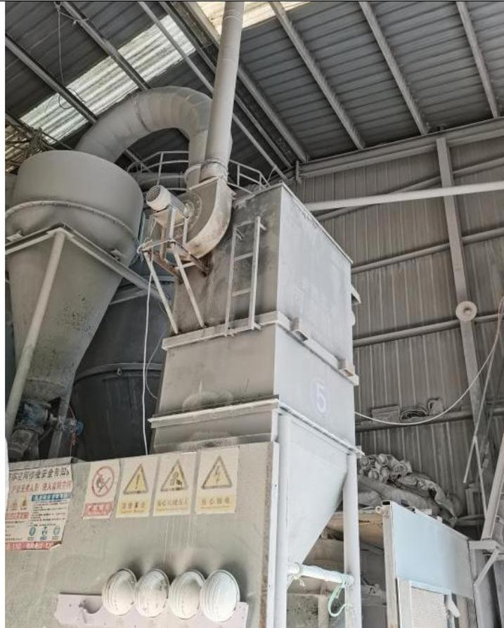
图 3-2 第二条粉磨生产线除尘器及排气筒（P3）
