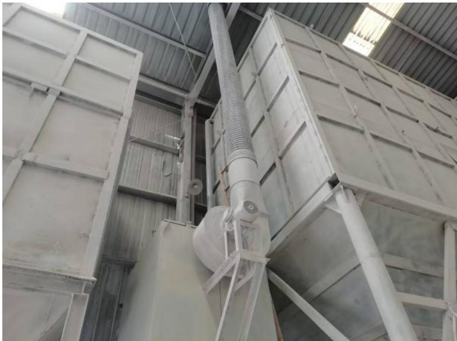
图 3-4 二号、三号产品储罐除尘器及排气筒（P5）
