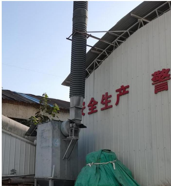
图 3-1 破碎工序除尘器及排气筒（P1）
