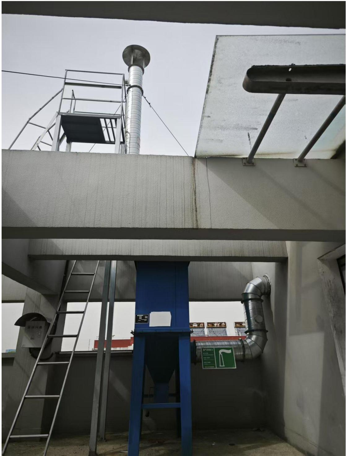
图 4-5 混料粉尘处理系统及排气筒（DA004）
