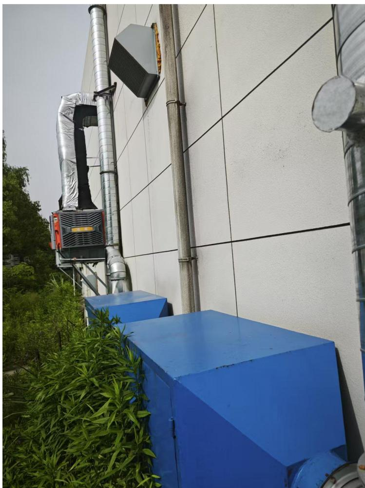
图 4-9 危废库挥发有机废气处理实施及排气筒（DA007）
