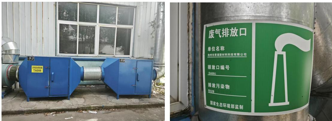
图 4-8 研磨工序产生的有机废气处理实施及排气筒（DA006）
