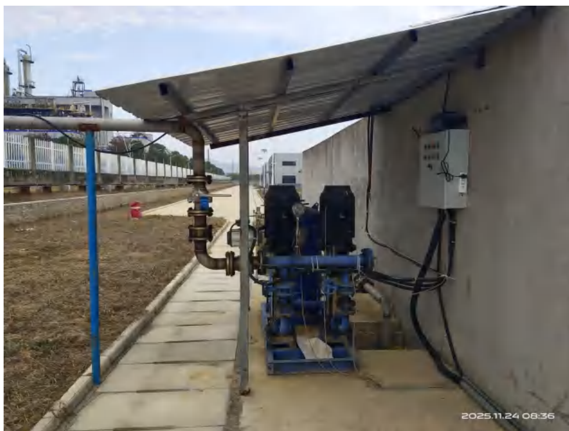
图 4-16 污水外送切断阀
