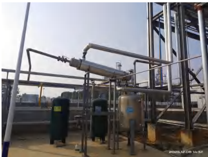
图 4-5 罐区废气收集及管道
