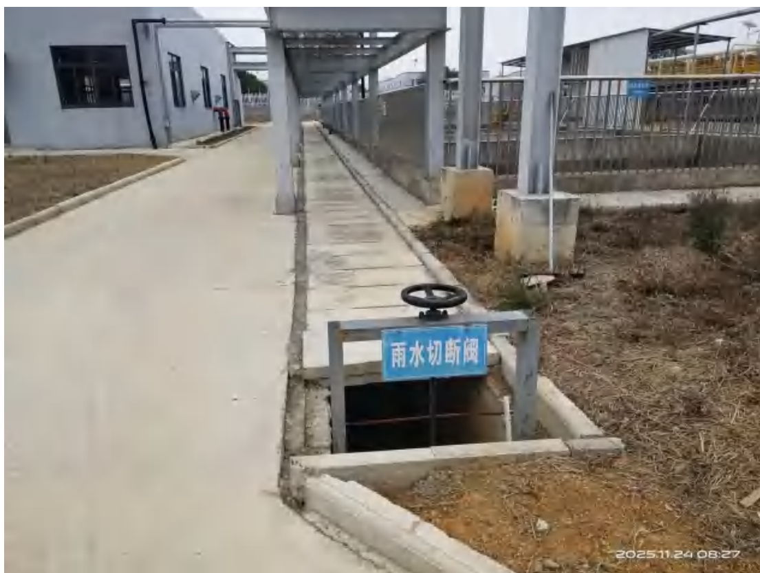
图 4-15 雨水切断阀
