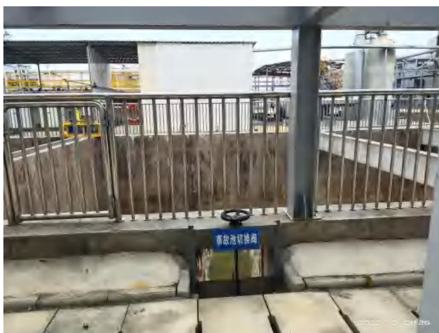
图 4-14 事故应急池及转换阀
