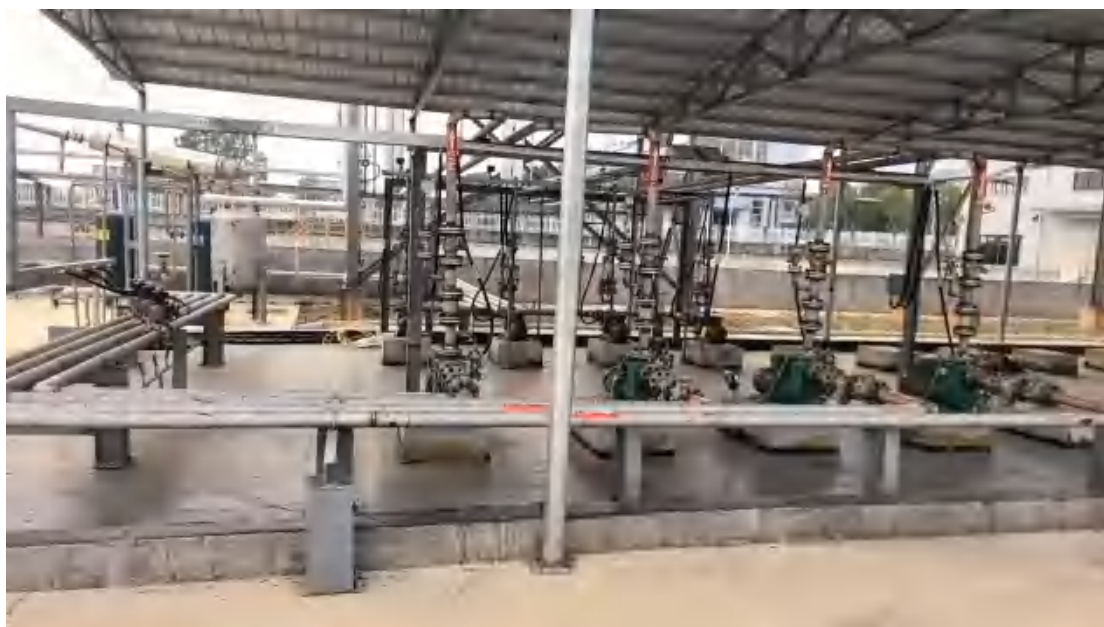
图 4-12 罐区及泵区围堰照片
