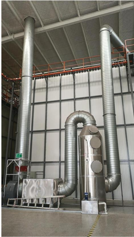
图 4-6 2#固化工序废气收集及处理设施
