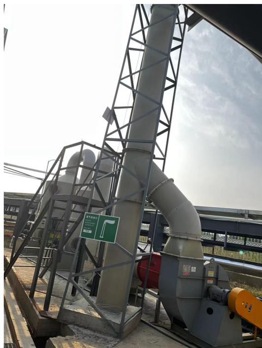
图 4.1-4 污水站及实验室废气治理设施及排放口照片
