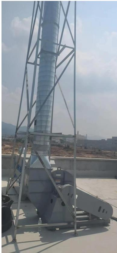
图 4.1-6 危废库废气治理设施及排气筒
